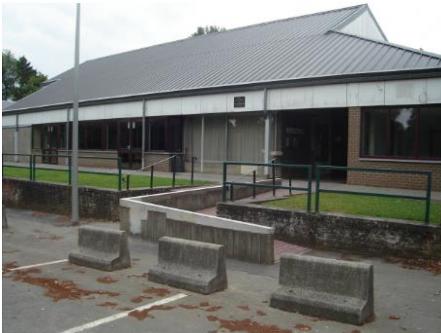
Entrée réaménagée avec rampe inclinée pour faciliter l'accès des personnes à mobilité réduite
